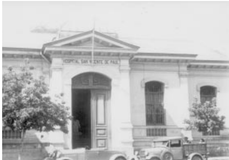
B. Hospital San Vicente de Paul. Se construyó entre 1873-1874. Fue Hospital Clínico de la Universidad de Chile en el período 1931-1952.
